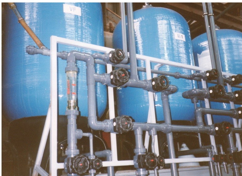
Bilder: Sonderanlage zur Quecksilbereliminierung im Rahmen der Altlastensanierung
